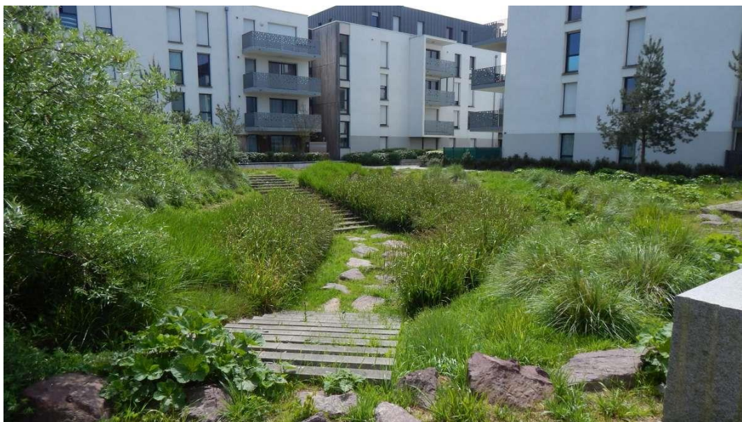
Expérience d'un "jardin de pluie" pour gérer les eaux pluviales sans tuyaux sur la parcelle. 37
