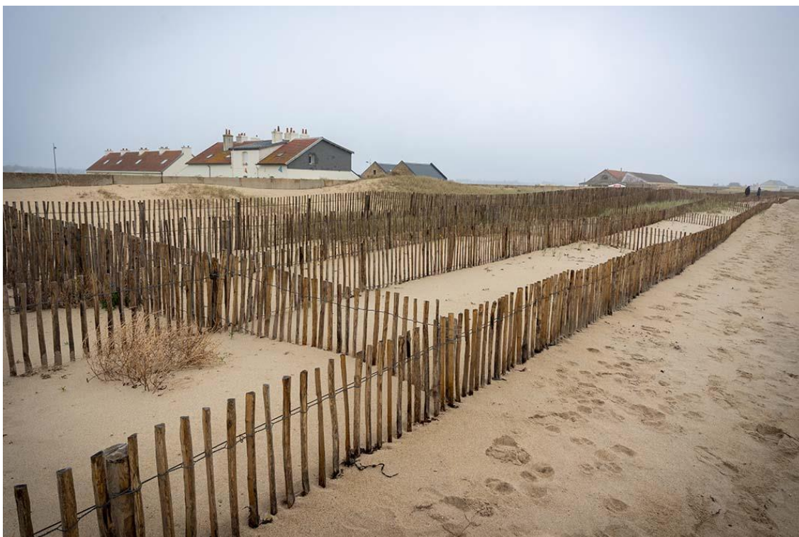
Dispositif de protection et régénération dunaire à Gâvres. Crédit photo : Lorient Agglomération.
