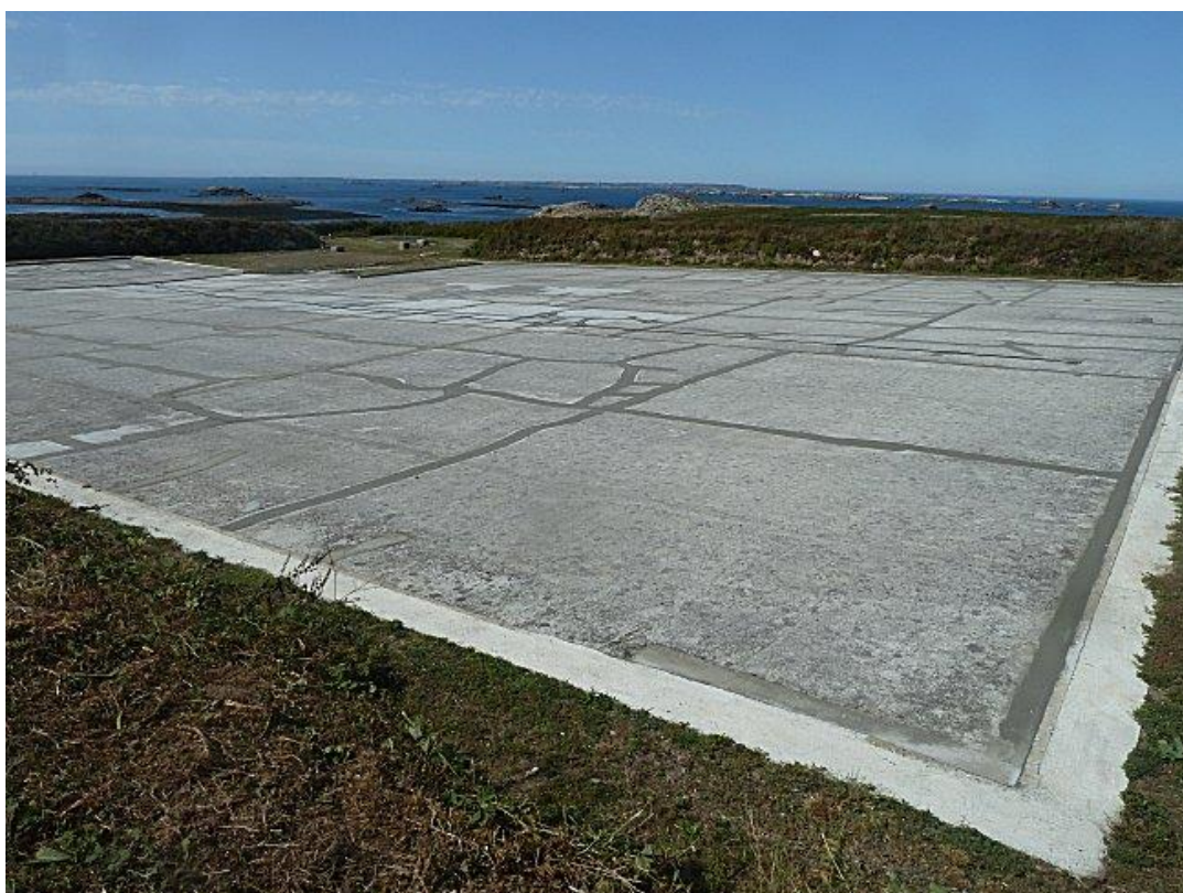
Système d'impluvium pour récupérer l'eau de pluie sur l'île de Molène 38
